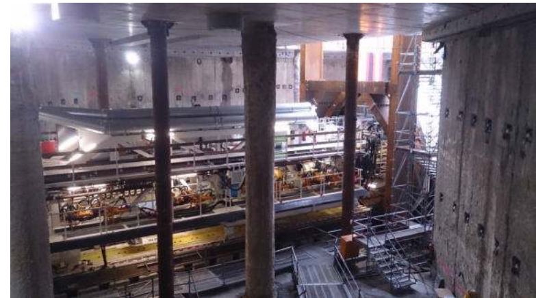
Baustelle der Kombilösung
