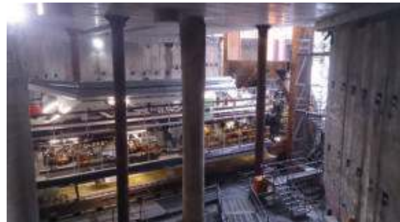
Baustelle der Kombilösung
