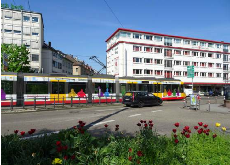
Straßenbahn am Karlstor
