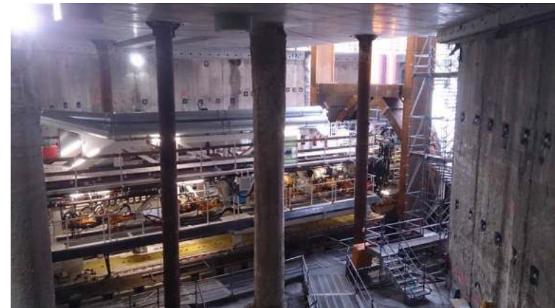
Baustelle der Kombilösung
